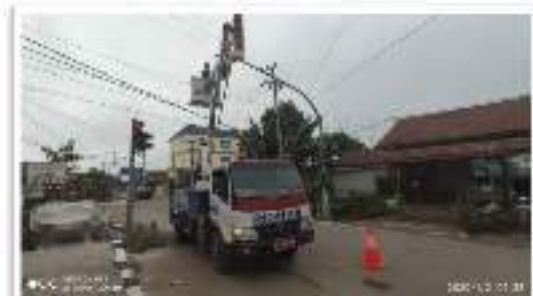
Gambar 1.1 Perbaikan dan Perawatan Traffic Light
