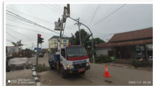
Gambar 1.1 Perbaikan dan Perawatan Traffic Light
