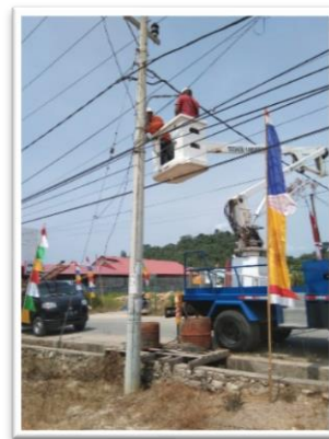
Gambar 3.3 Perbaikan Lampu Penerangan Jalan Umum
