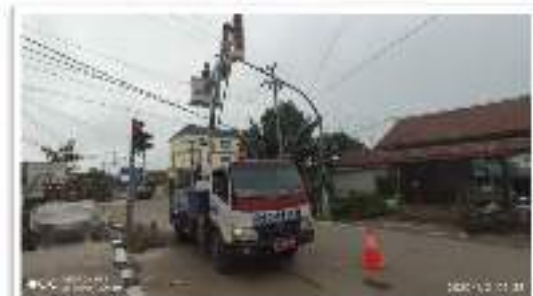
Gambar 1.1 Perbaikan dan Perawatan Traffic Light
